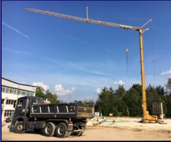
Der Kran steht schon mal ...
